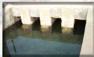
Canal de entrada de agua desde el Mar Menor a Pie de Noria en el molino de la Calcetera
