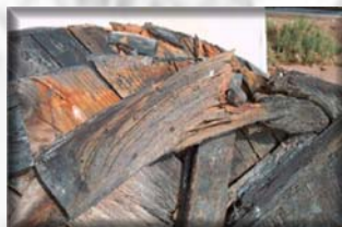
Detalle del estado de las maderas de las norias
