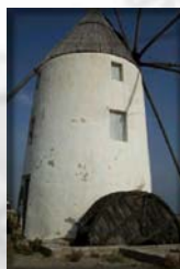
Obsérvese la ausencia de plataforma para elevar el nivel del molino
