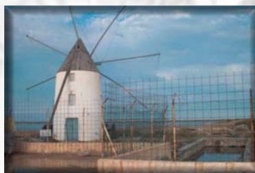
Situación actual del entorno del molino de la Calcetera
