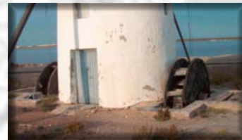
Detalle de arquetas de recepción del agua a través de canales soterrados en el entorno del molino
