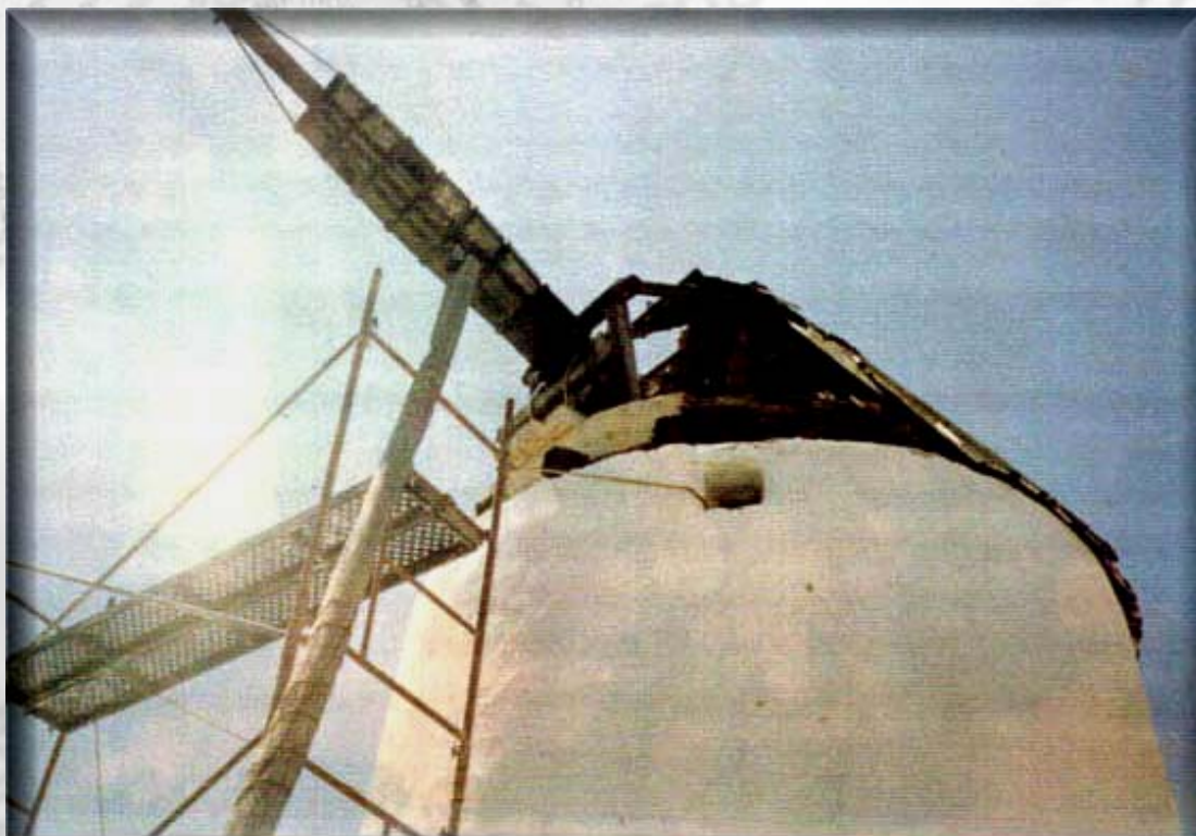
SUSTITUCION DE ELEMENTOS DAÑADOS EN LA CARPINTERIA
