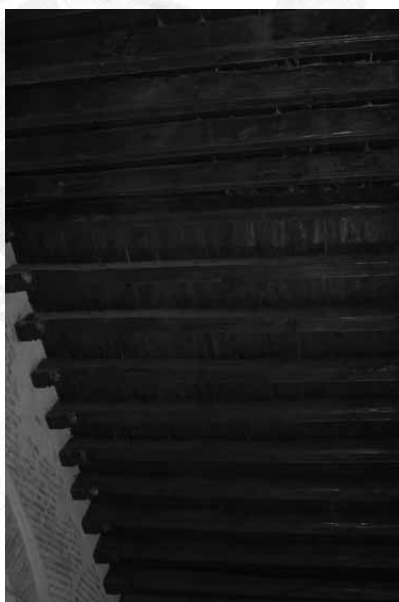
Lámina 9. Artesonado de madera después del tratamiento de restauración. (Foto: J. García).
