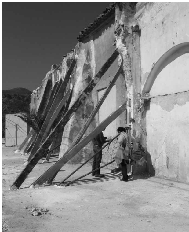
Lámina 5. Estado de conservación de uno de los laterales de la ermita antes de la intervención. (Foto: M. L. Precioso).
