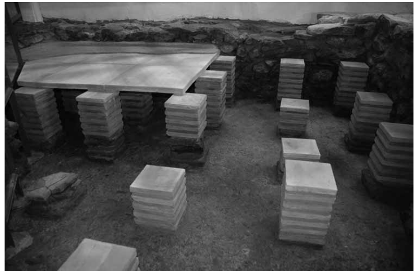
Lámina 2. Hipocaustum después de la intervención de reintegración estructural en las pilstras y el sistema de suspensión. (Foto: J. García).
