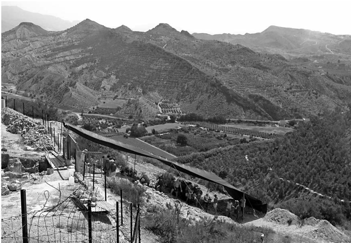
Lámina 2. Área de excavación.
