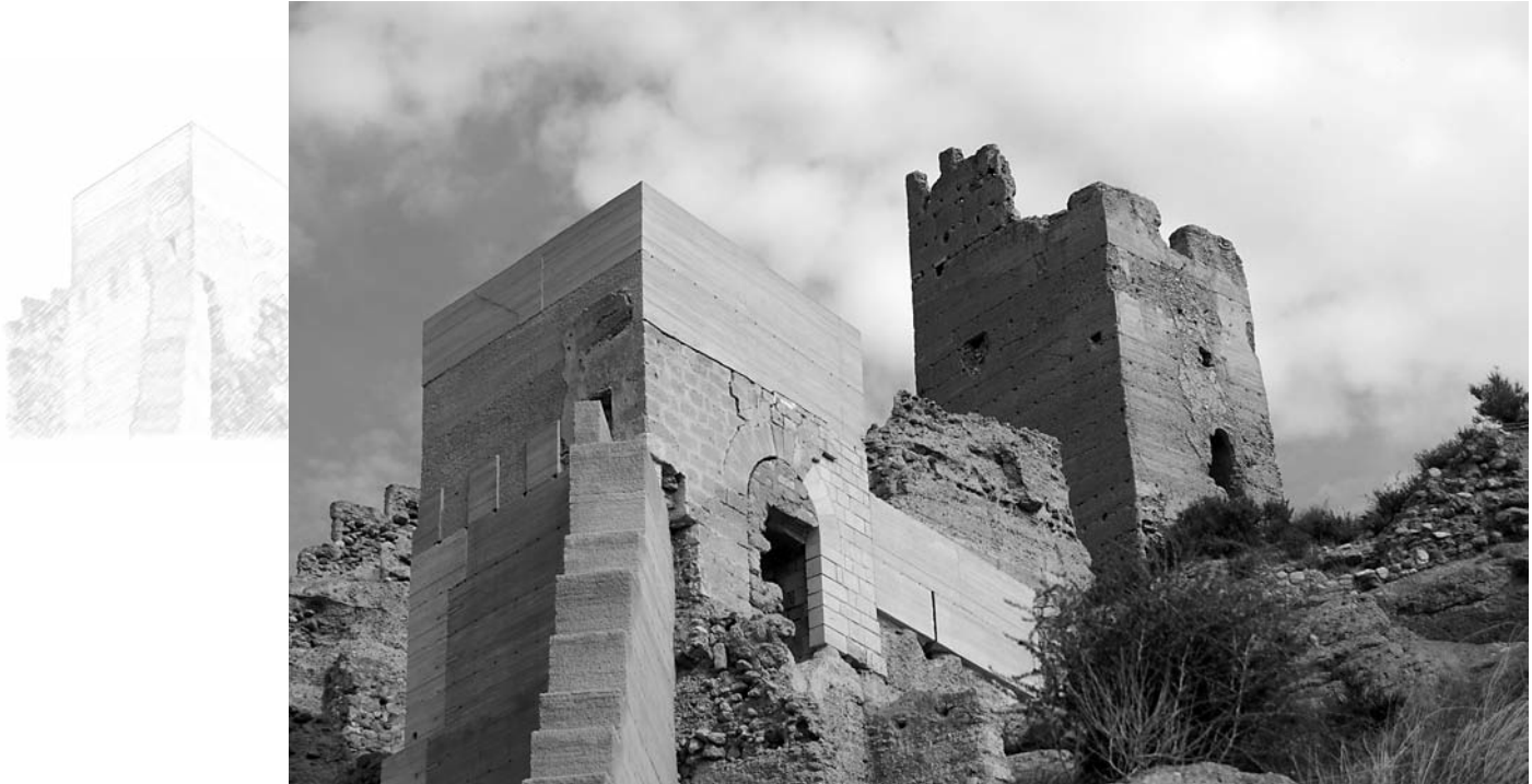
Lámina 2. Castillo. Torre de entrada al recinto superior. II fase de la restauración.
