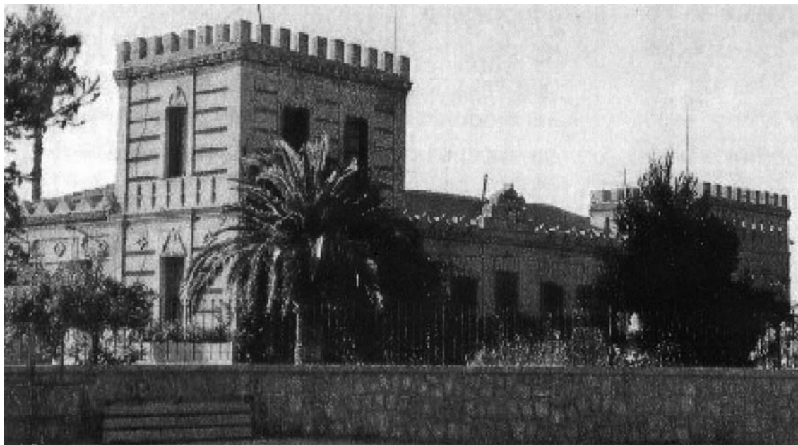
Lámina 1. Vista exterior de la fachada oriental con las dos torres en los extremos.
