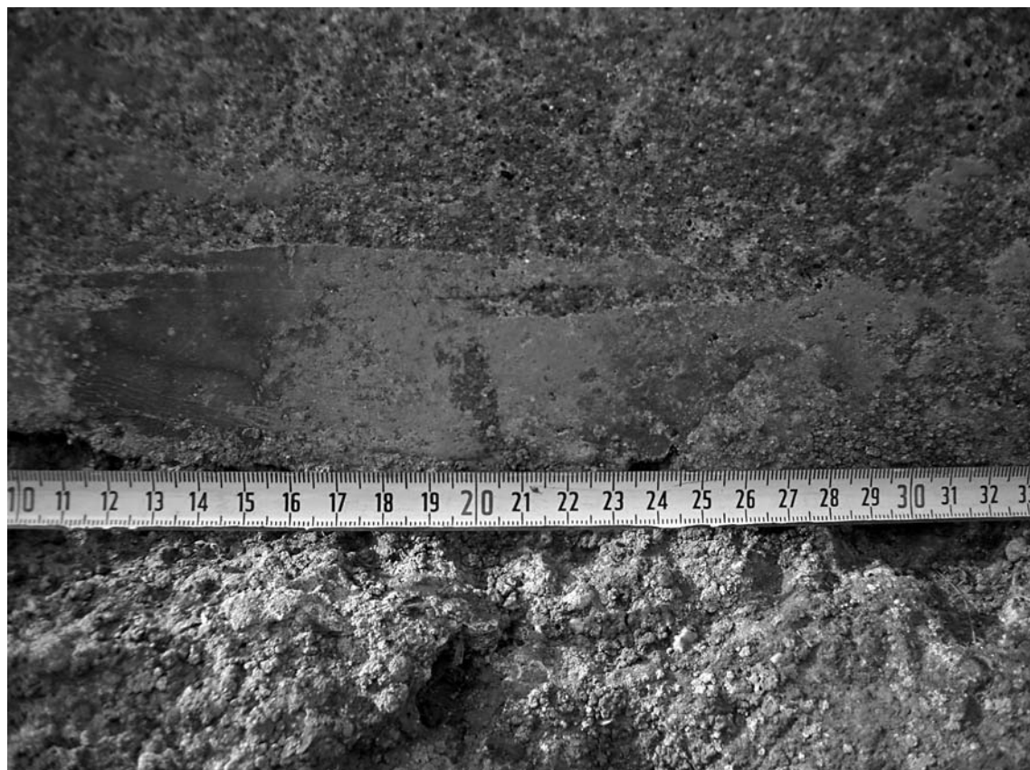
Lámina 2. Detalle de enlucido rojo de la torre del Molino del Tío Damián.
