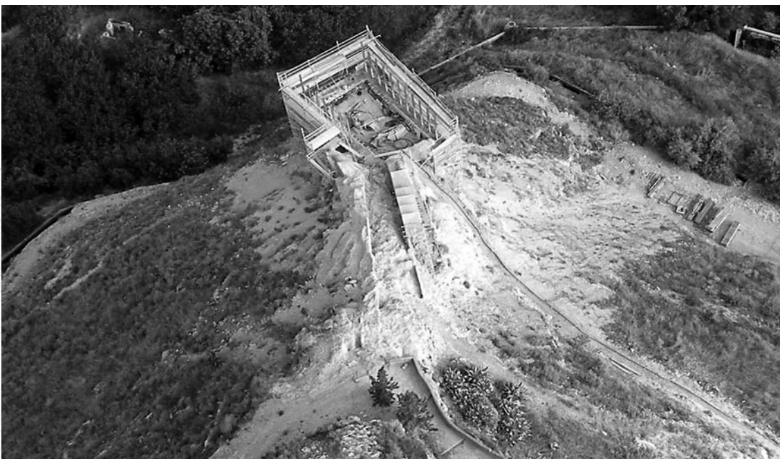
Lámina 3. Vista de la torre con el camino de acceso o adarve en primer término.
