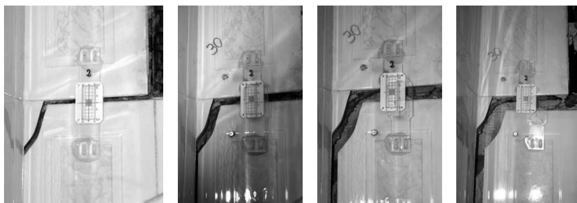
Figura 1. Detalle de la puerta de acceso abierta. Al cerrar, todos los elementos metálicos quedan ocultos. (Foto: M. San Nicolás).
