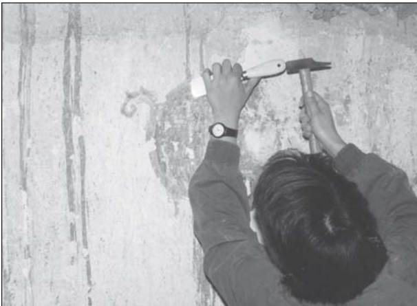
Lámina 6: Fase II. 1. Limpieza de mecánica de depósito de cemento.
