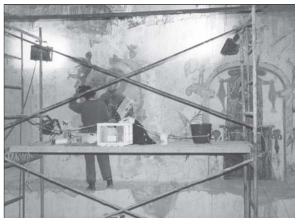
Lámina 3: Medios auxiliares de trabajo: sistema de andamios modulares móviles e iluminación cruzada indirecta.
