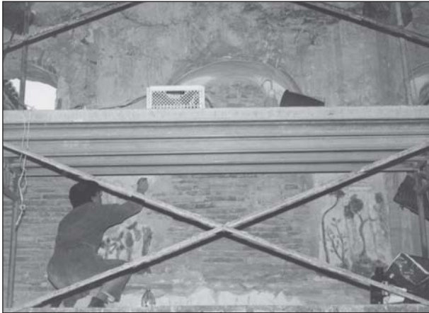
Lámina 4: Fase II. 1. Limpieza superficial.
