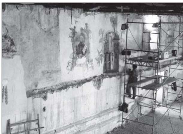
Lámina 2: Proceso de restauración. Reconocimiento inicial del estado de conservación de los distintos paños pictóricos.
