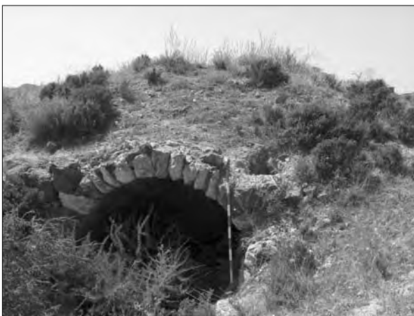
Lámina 5. Entrada a la galería del horno n.º 1 (Fundición de Lo Rizo, El Algar).
