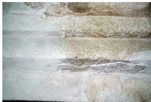
LÁMINA 20. DETALLE DE LA REINTEGRACIÓN CROMÁTICA, SE OBSERVA EL ESCALÓN DE UNOS MILÍMETROS DEL ORIGINAL SOBRE LA REINTEGRACIÓN. (FOTO: J. GARCÍA SANDOVAL)
