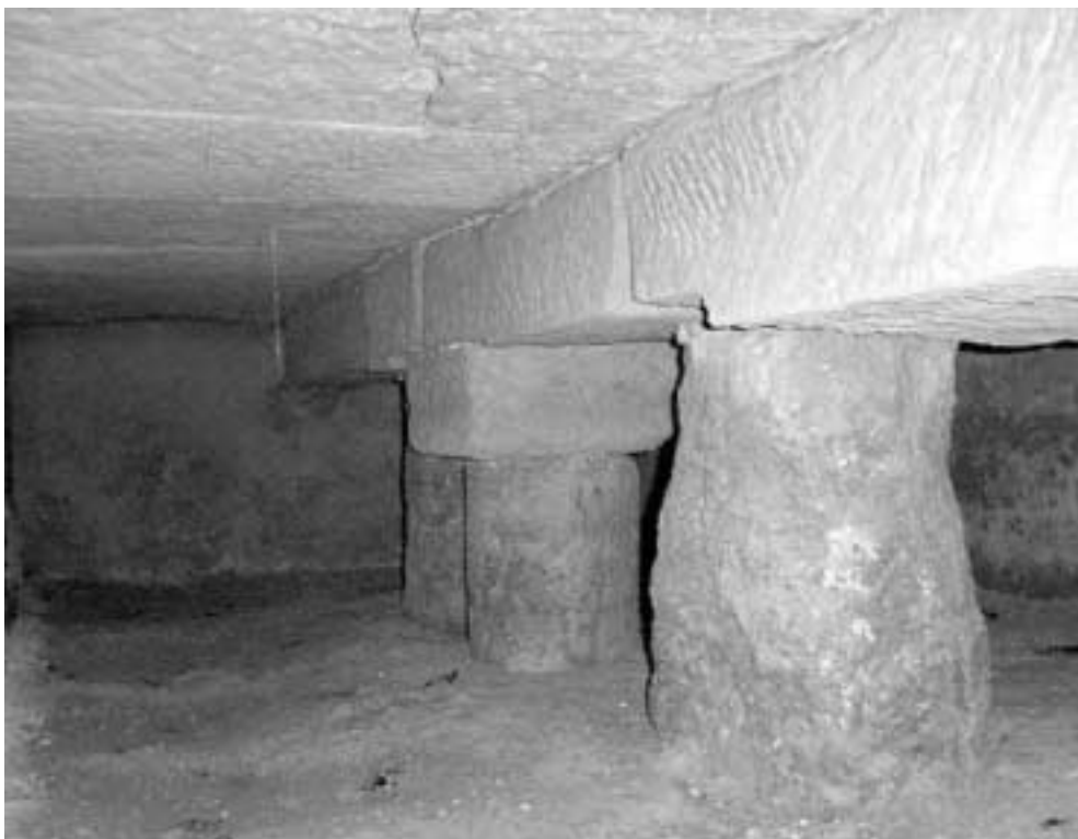
Interior de la cisterna subterránea
