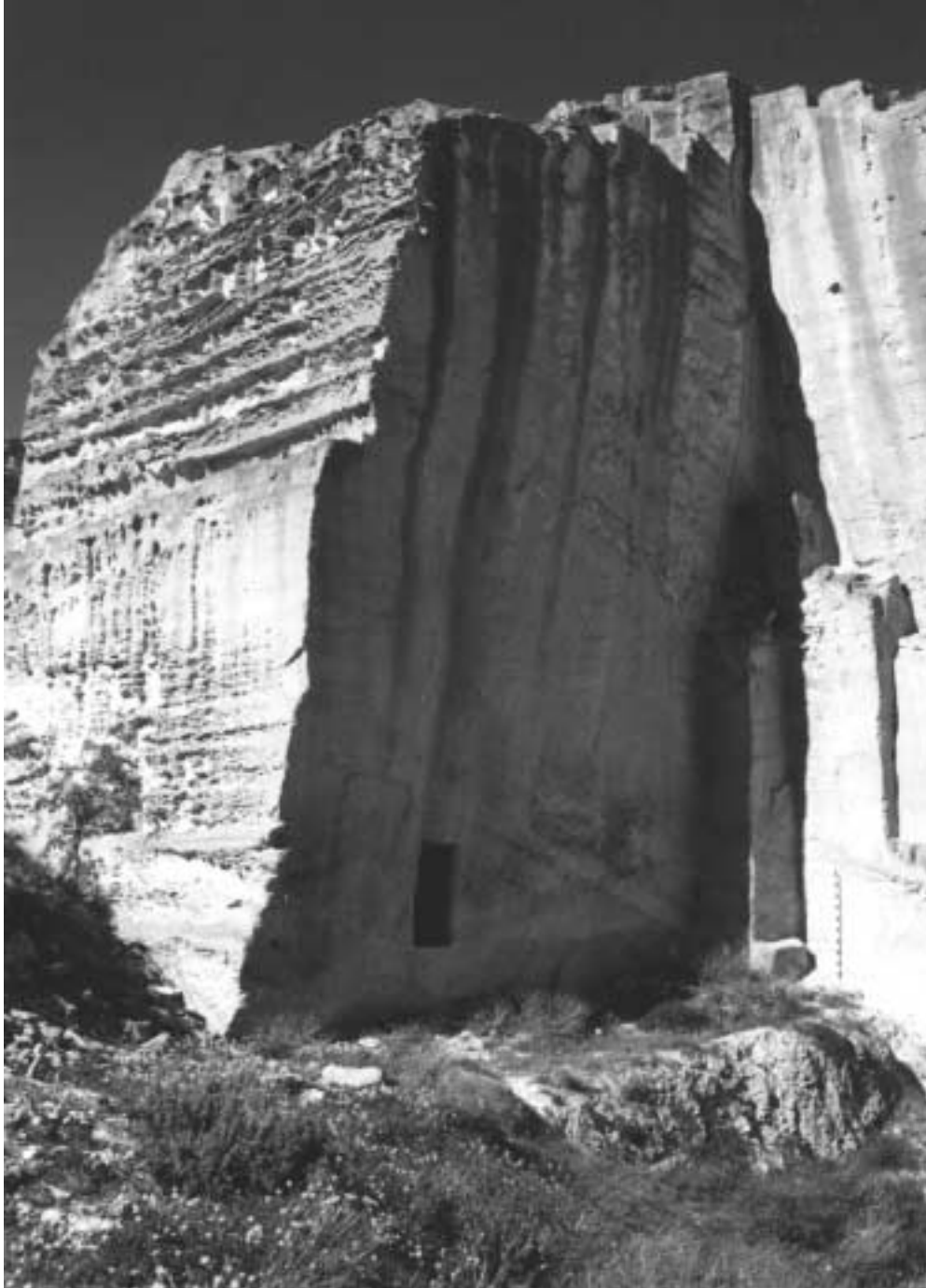
Frente de explotación perteneciente a las canteras romanas de arenisca, de más de 15 m de altura
