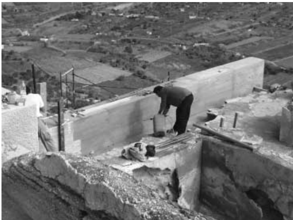
Trabajos de consolidación en el yacimiento
