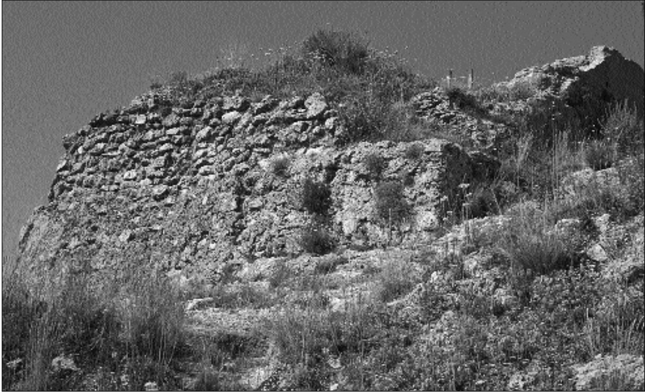
Lámina II. Fotografía I: Torre NE. Vista exterior vértice E.
