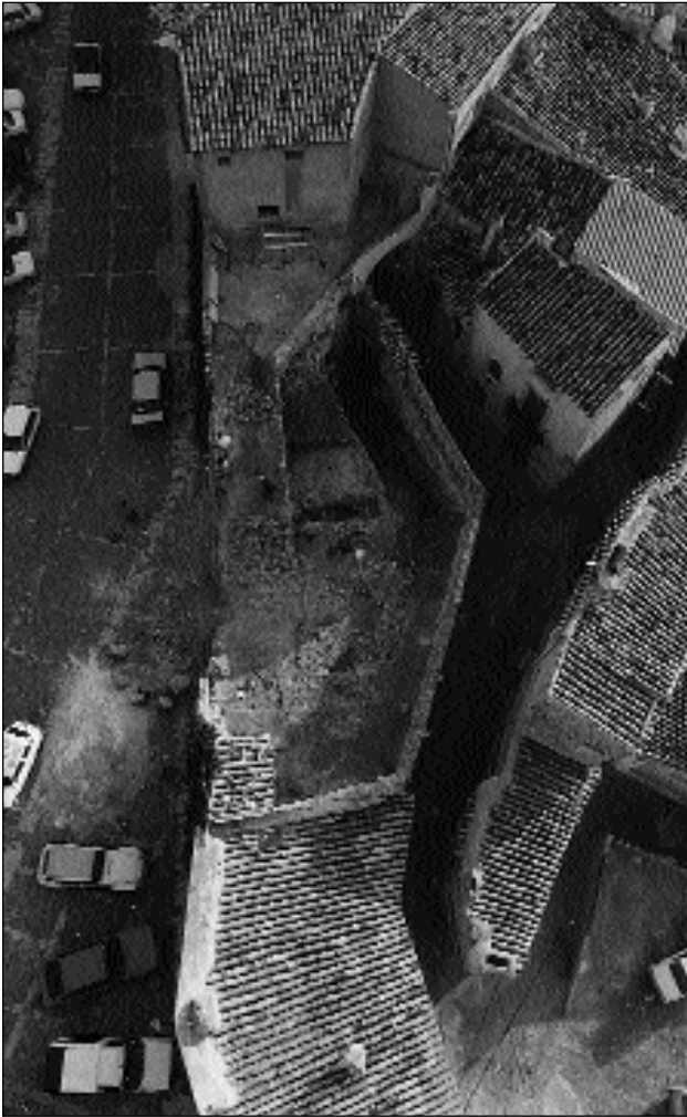
Fig. 6. Patio de Los Fajardo: Panorámica aérea al comienzo de la excavación.
