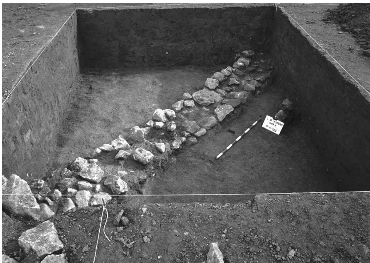
Lámina 2. Muro alterado por una fosa séptica.
