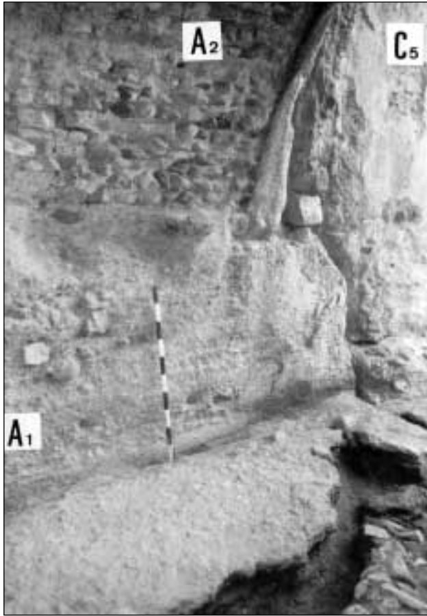
Figura 8. Detalle del interior del Acueducto Alquibla: pila (A1), bóveda (A2), y acople de una de las pilas del acueducto de la Dava (C5).
