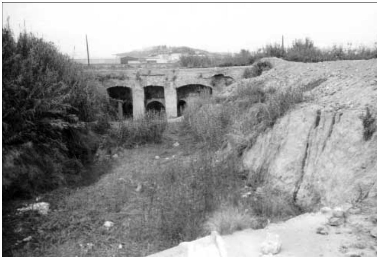
Figura 3. Fachada Este de los acueductos, vista desde el río Segura.
