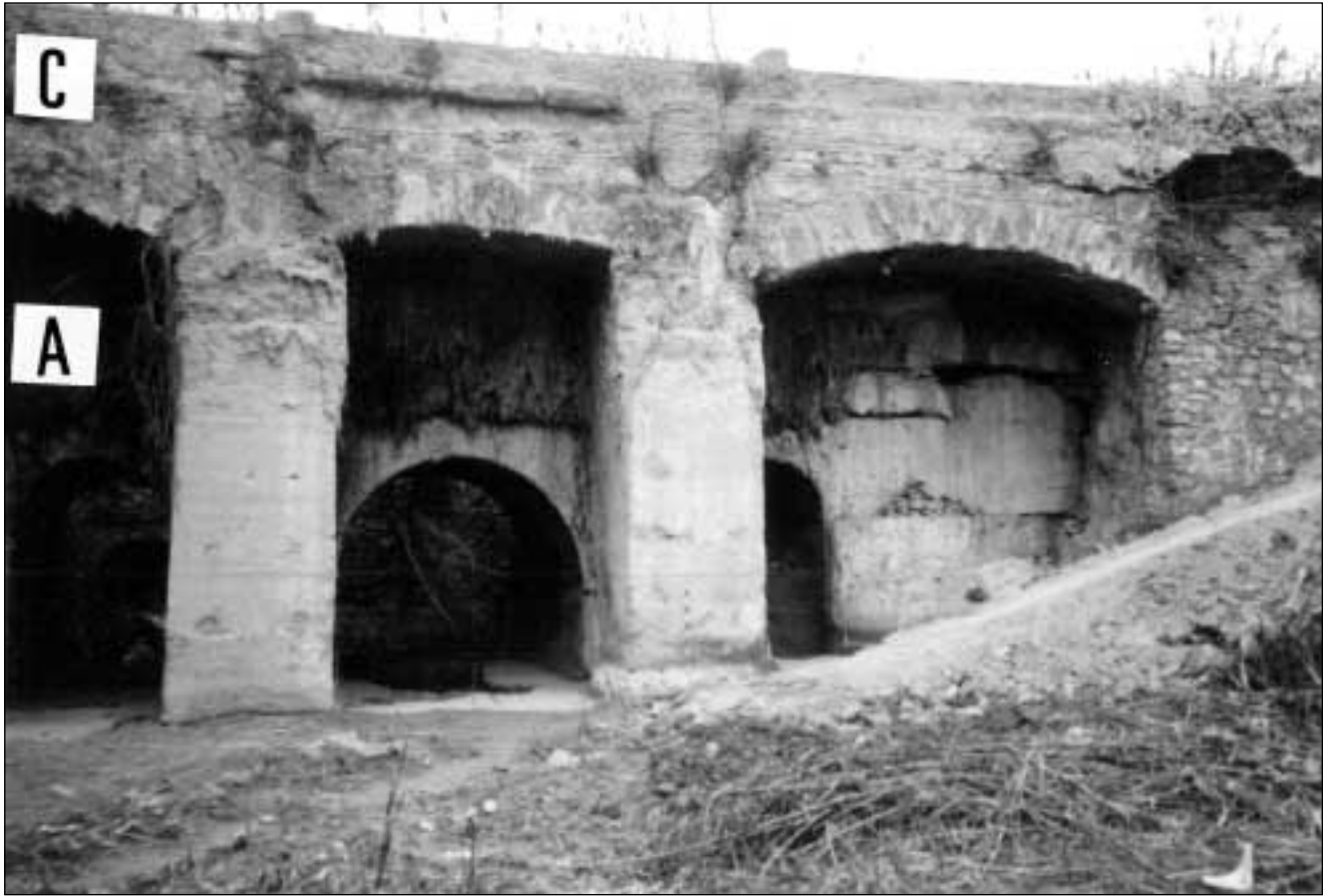
Figura 4. Detalle del adosamiento del acueducto de la Dava (C) ante el acueducto de la Alquibla (A), vista Este.
