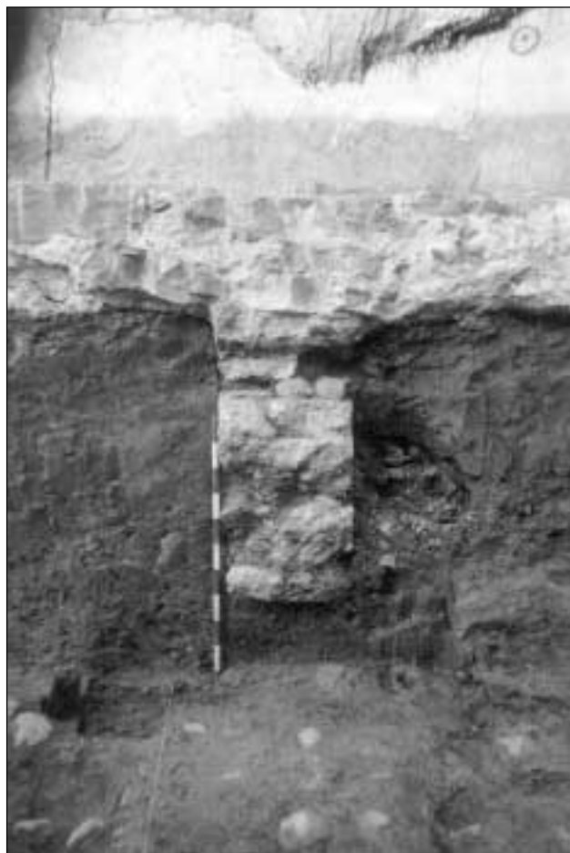
Figura 17. Detalle de la sección de la solera de la fase de ensanche (Turbedal).
