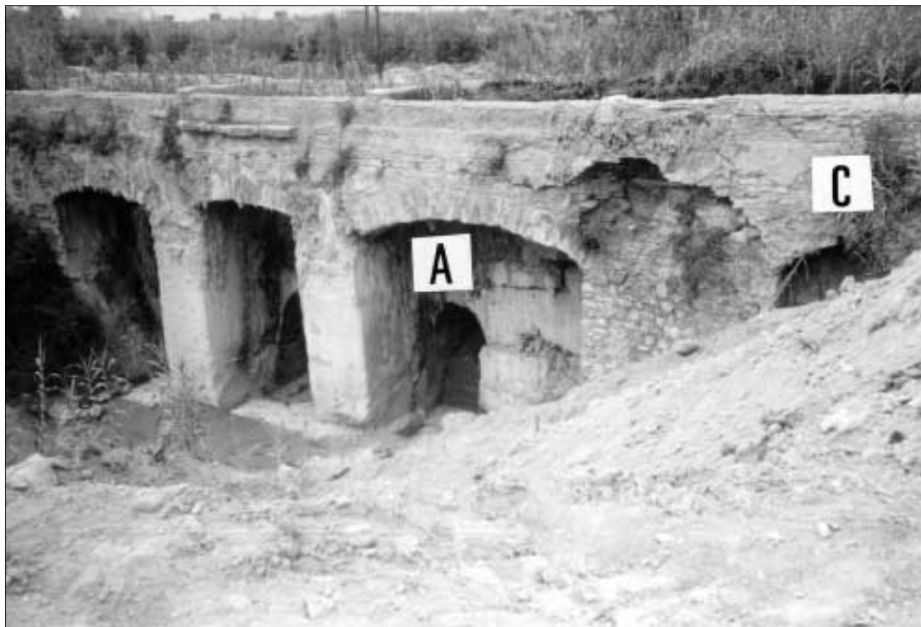
Figura 5. Vista Este general de los acueductos adosados: la Dava (C) y Alquibla (A).
