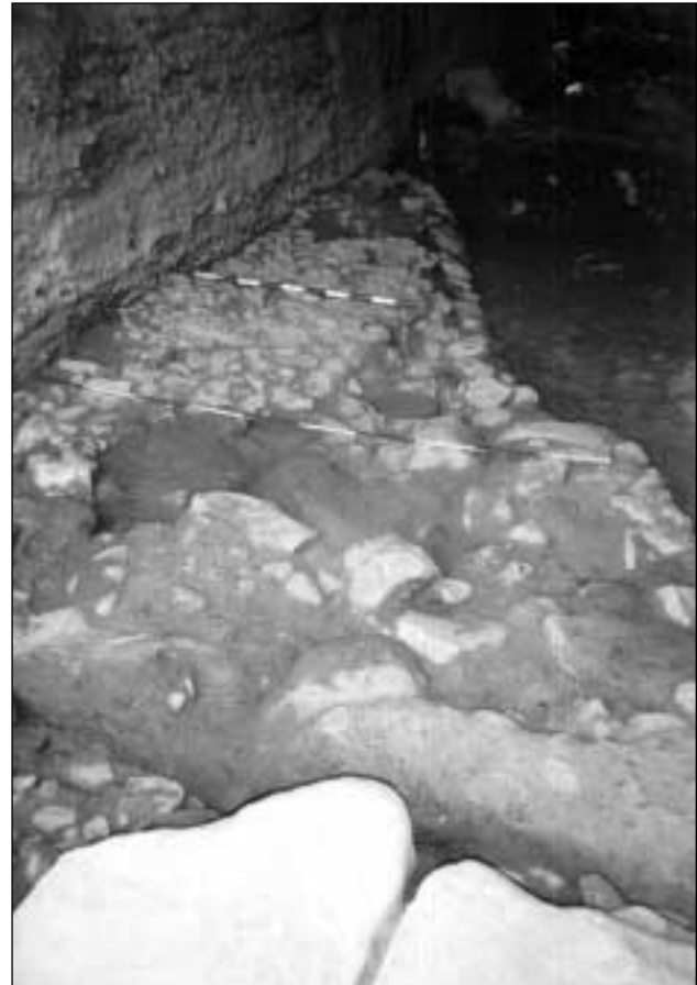
Figura 12. Detalle de la obra de la contrabóveda efectuada en el interior de los acueductos.
