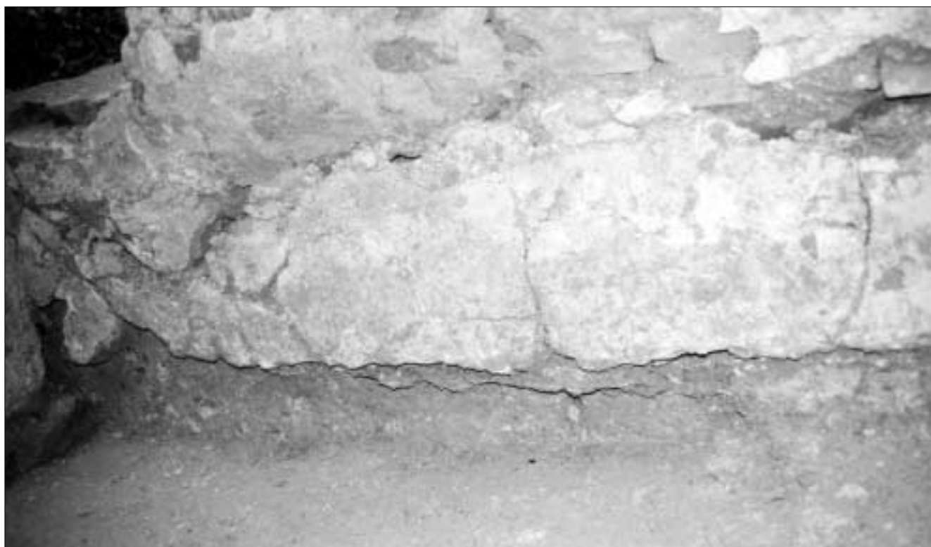
Lámina 3. Detalle del estuco en el muro medianero del salón, vivienda 1, fase de fundación.
