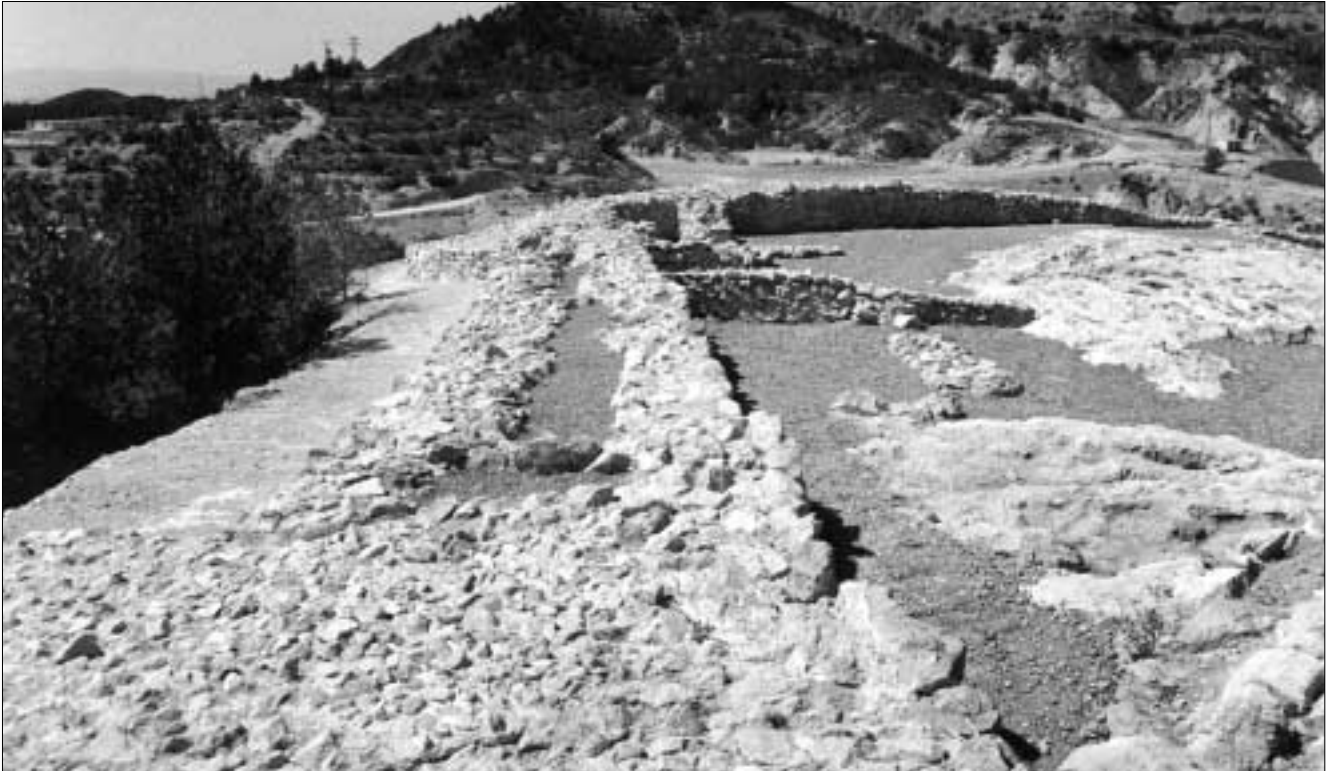
Lámina 1. Tramo SE de la muralla. Obsérvese en primer plano el bastión y la estructura de la muralla, con dos muros paralelos unidos por tirantes y pasillo central de tierra compactada. Intramuros, viviendas adosadas.
