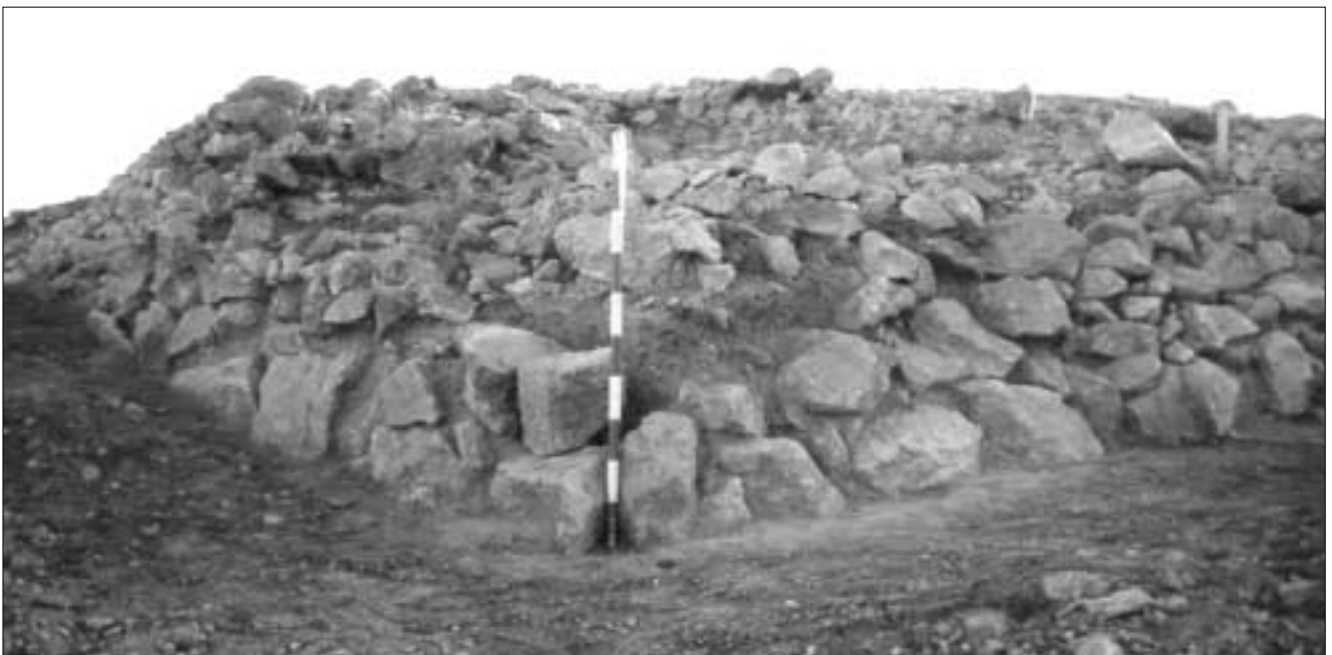
Lámina 5. Detalle del contrafuerte exterior del Bastión 3, adosado al alzado.
