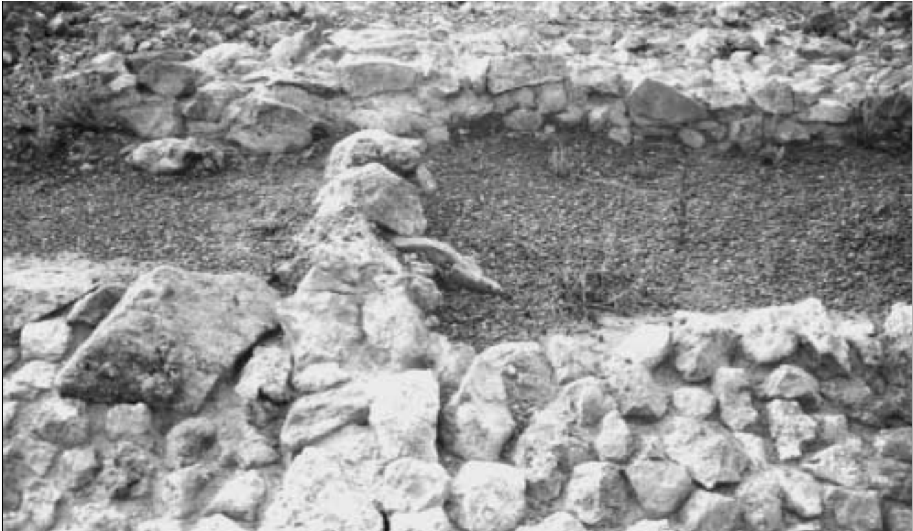
Lámina 8. Detalle de un tirante interno de la muralla, finalizados los trabajos de consolidación y adecuación a visitas.
