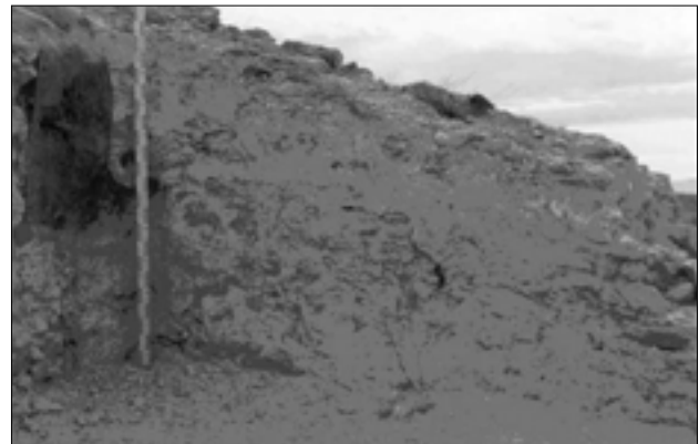
Lámina 11: Paramento exterior, enlucido de cal y arranque de torreón de la muralla.
